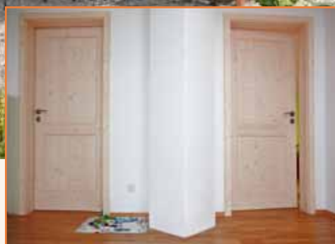
Mit Rötzer-Ziegel-Element-Haus sind auch unkonventionelle Lösungen möglich: Damit der offene Kamin im Wohnzimmer den gewünschten Winkel hat, wurde der Schornstein einfach um 45 Grad gedreht.
